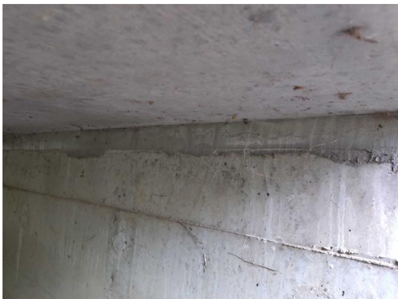
Detail uložení NK na opěru.
