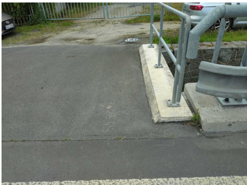
Vegetace ve spáře napojení ka hlavní silnici a u římsy.
