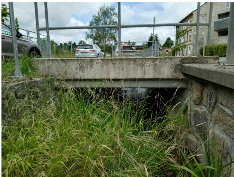
Pohled na výtok s degradovanou římsou v napojení na nábrežní římsu.
